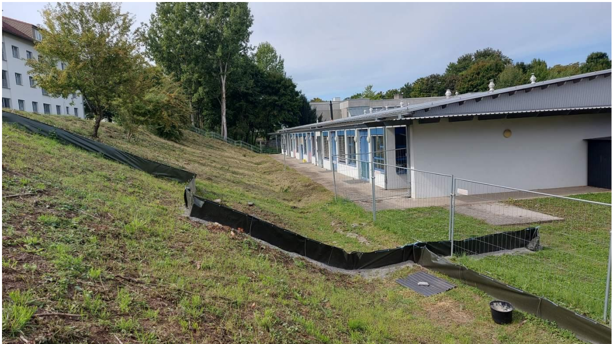
Abb. 10 (Anhang): Mit dem Reptilienzaun umgebene Eingriffsfläche Blick nach Westen auf das Gebäude des Kindergartens. Da um die neu umrissene Außenfläche des Kindergartens ein Kindergartenzaun errichtet werden sollte, ist der Reptilienzaun im August 2025 dort – wie auf dem Foto zusehen – etwas zurückversetzt worden. Vorne rechts befindet sich ein künstliches Reptilienversteck (Aufnahmedatum: 11.08.2025).
